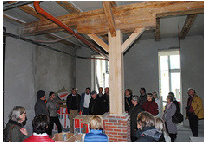
Blick auf die alten und die neuen Balken der 1913/1914 errichteten Kattau-Mühle am Hafen in Buxtehude. Foto Vasel.
