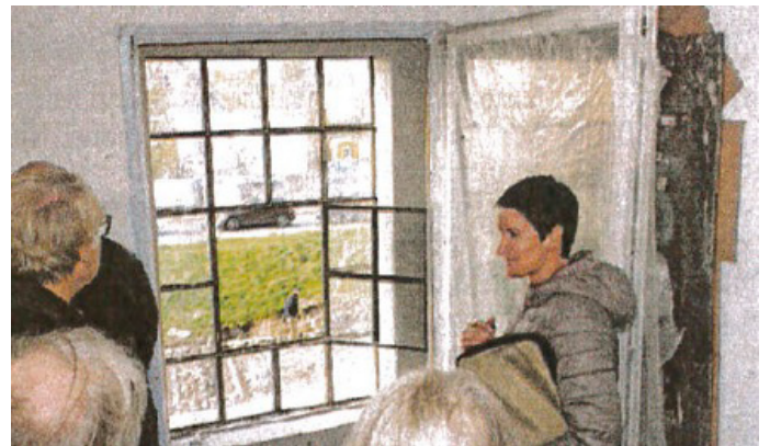
Architektin Claudia Körner (Büro kbnk) vor einem der 56 restaurierten gusseisernen Fenster. Foto Vasel.
