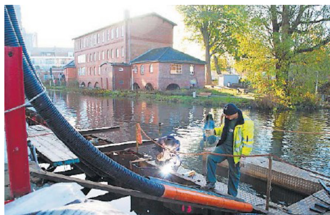
Eine Spundwand wird an der Hafen-Seite errichtet, um das marode Mauerwerk der Mühle zu sanieren. Gegenüber liegen Malerschule und das Kulturforum.
